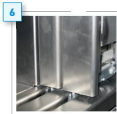
Verstärkte Türblattversteifungen und verstärkte Türblattführung (Kategorie 2)
