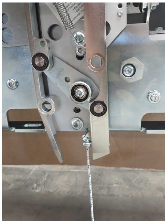
Bild 24: Entriegelung der KTV (G2)
