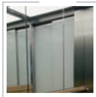
Panneau miroir (VSG**), avec joint creux vertical
